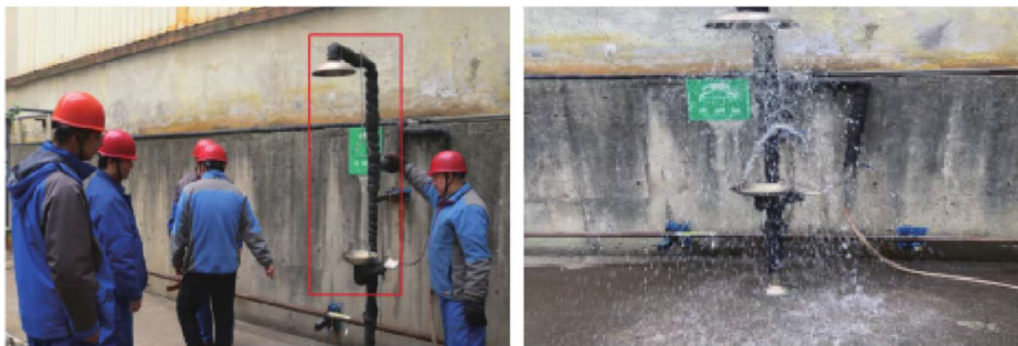
洗眼器水压检查
